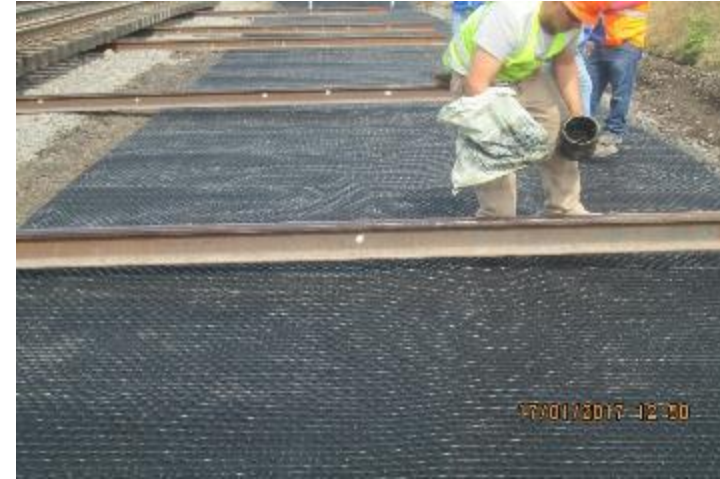
Movimiento de Vía
