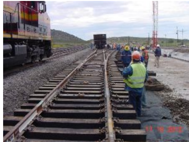
Colocación de Balasto
