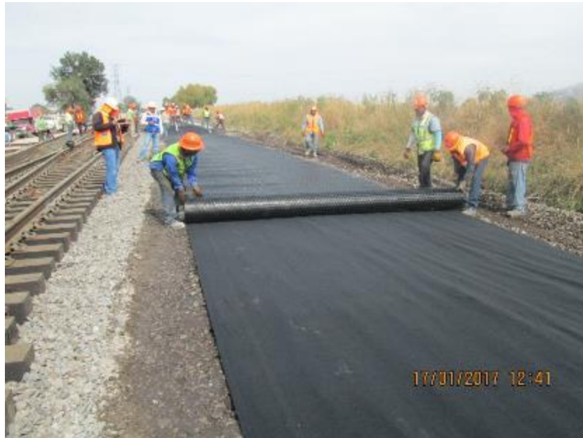
Instalación de Geomalla y Geotextil
