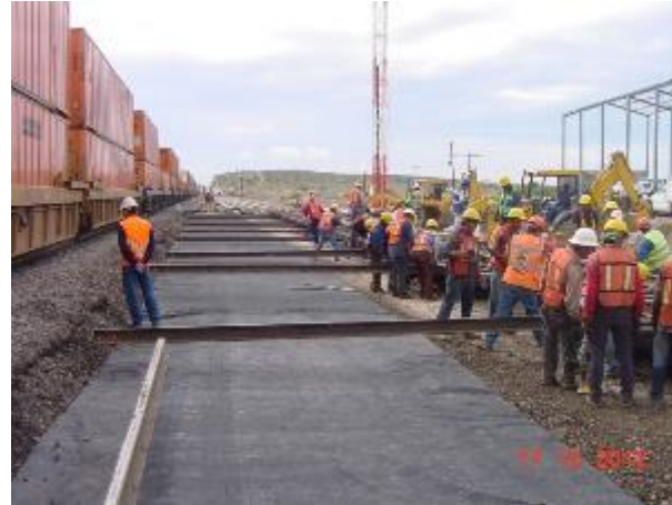
Movimiento de Vía
