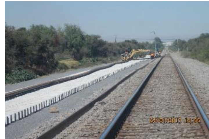
Instalación de Rieles
