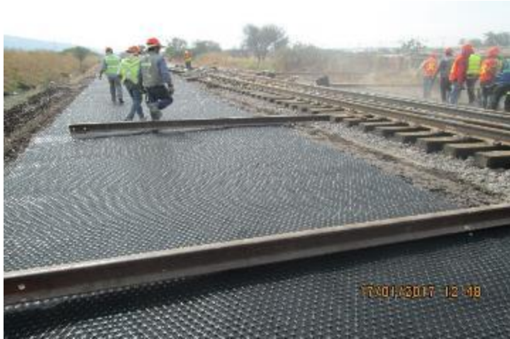
Movimiento de Vía
