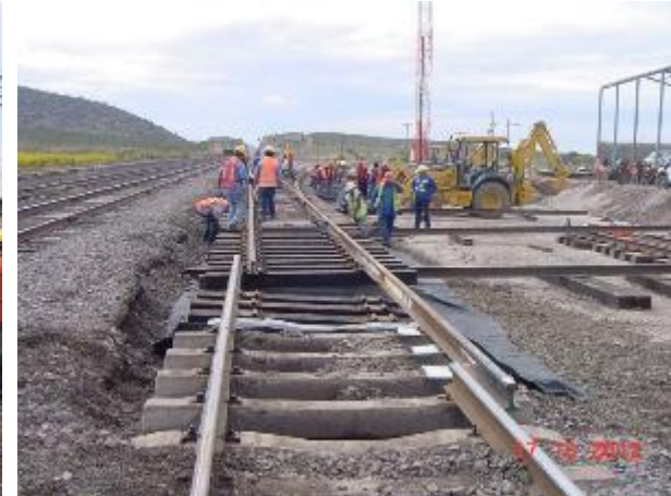
Instalación de Rieles
