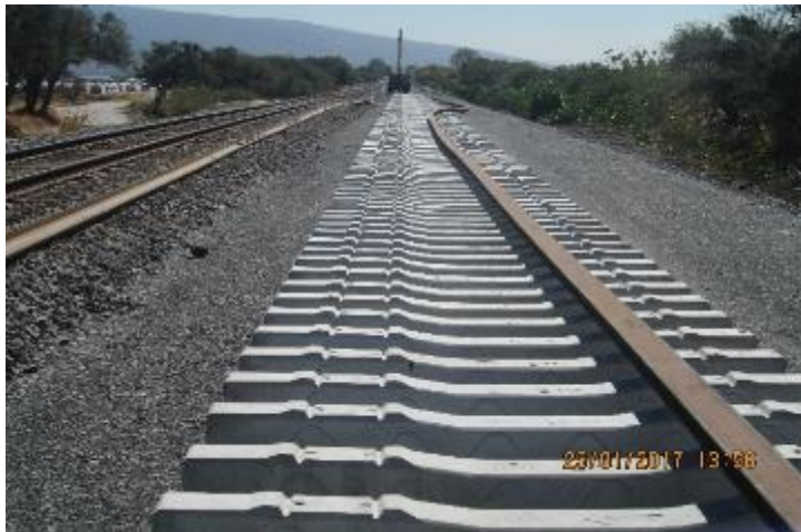
Instalación de Durmientes
